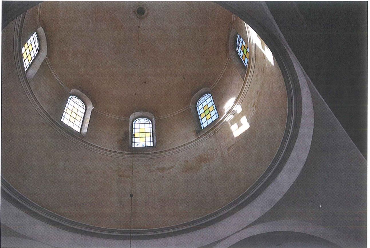
Zdjęcie 6 Widok głównej kopuły od środka Autor: Dr Inż. Eugeniusz Zawaleń
