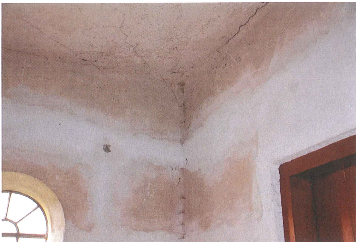
Zdjęcie 8 Uszkodzenie stropu i ścian w północnej zakrystii Autor: Dr Inż. Eugeniusz Zawaleń
